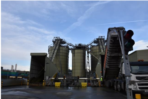
Figura 2: Central de Recebimento de lodo desidratado não digerido da ETE de Davyhulme na Inglaterra operada pela United Utilities
