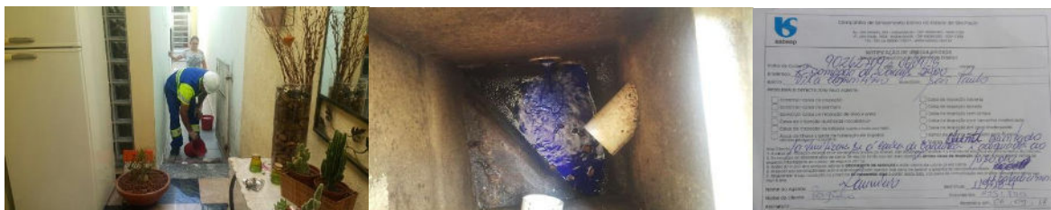
Figura 5 – Fotos de vistoria de águas pluviais e notificação para regularização
