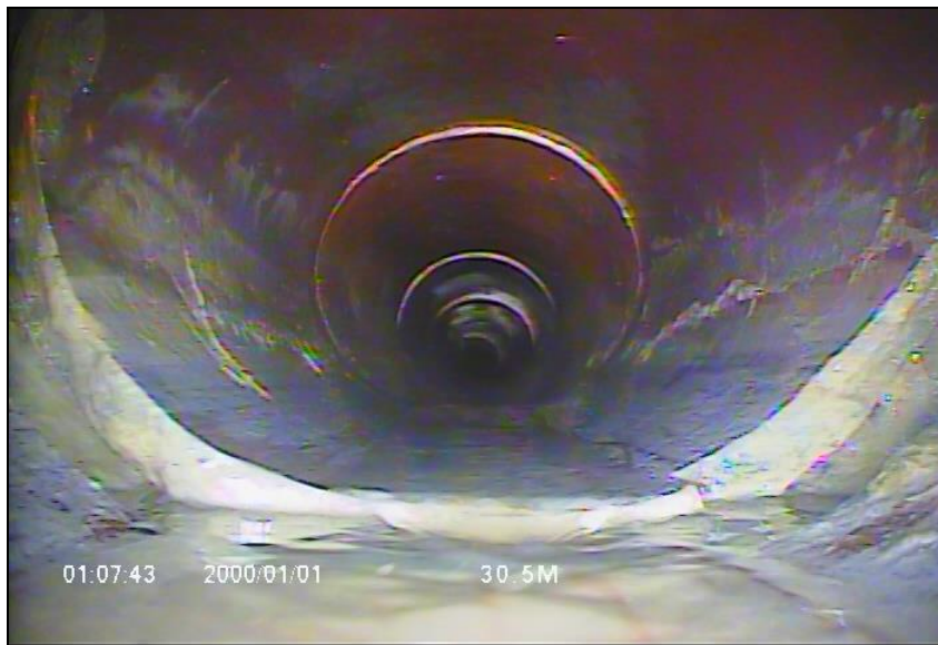
Figura 4 – Filmagem vídeo inspeção de rede de esgoto
