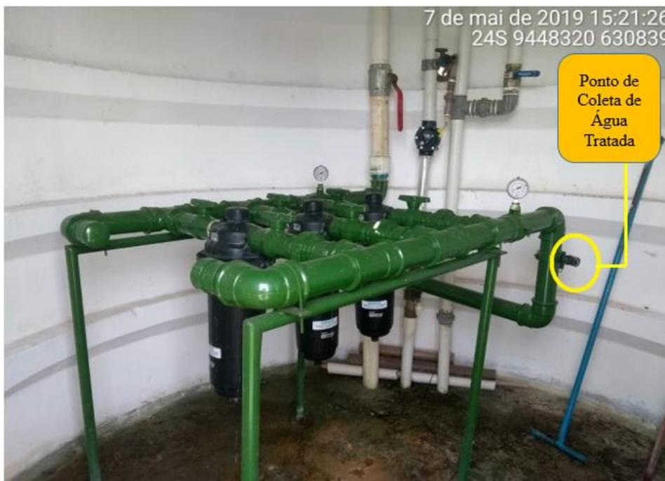
**Figura 2: Ponto de coleta de água tratada – Equipamento Troca Iônica.**
