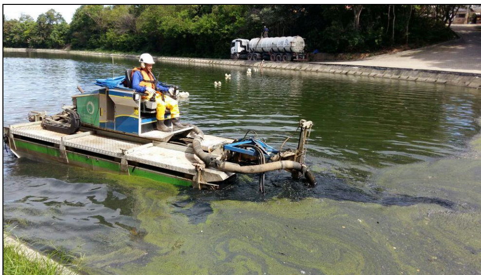
Figura 3 - Operação de dragagem de lodo na ETE.
