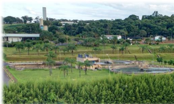
Figura 4 - Vista dos Decantadores Primários.
