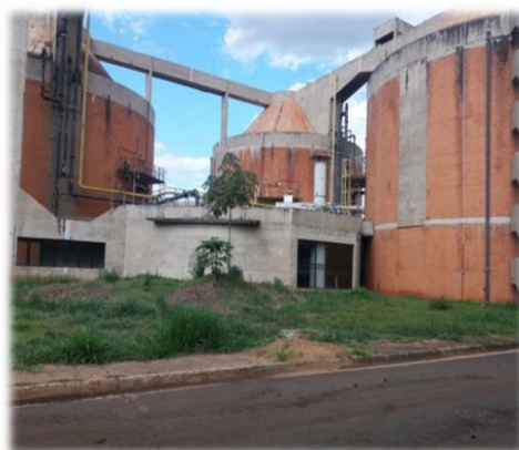
Figura 6 - Digestores Anaeróbios de Lodo.
