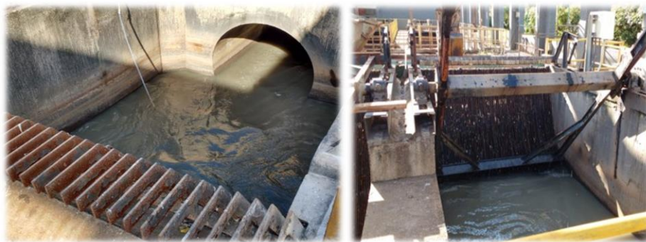
Figura 3 - Grade grossa (à esquerda) e grade fina (à direita).
