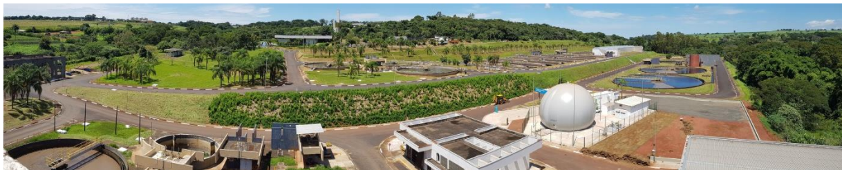
Figura 1 - Vista panorâmica da ETE Franca.
