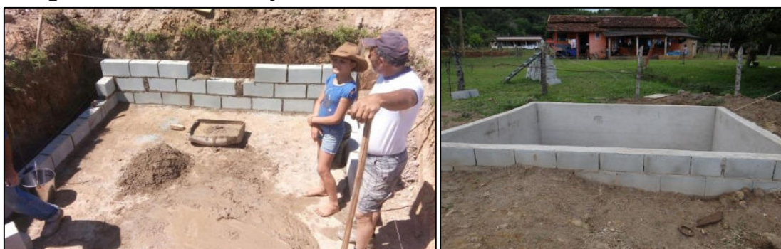
Imagens 1 e 2 – Construção da alvenaria cimentada.
