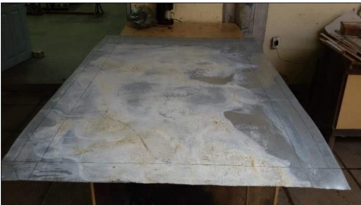
Figura 12 - Marcação prévia para dobramento da chapa de aço galvanizado
