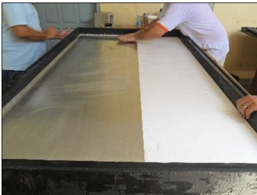
Figura 14 - Aplicação do isolamento térmico na caixa do coletor
