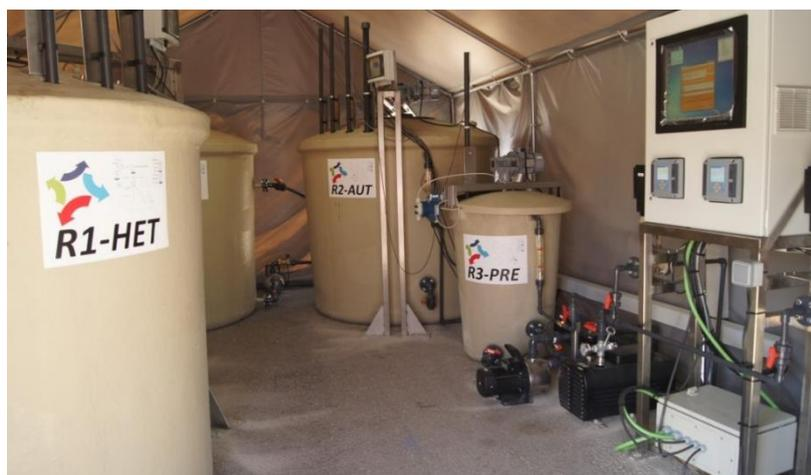
**Figura 23: Reatores Sequenciados** <sup>5</sup>.
