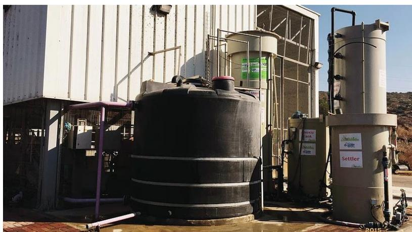
**Figura 21: ETE Karmiel - Tratamento anaeróbico de resíduos** <sup>28</sup>.
