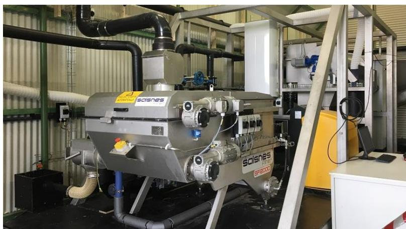
**Figura 19: Sistema de filtro Salsnes instalado na ETE Geestmerambacht** <sup>24</sup>.
