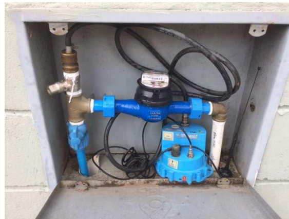
Figura 2 - Aspecto da instalação de ponto de monitoramento remoto de pressão
