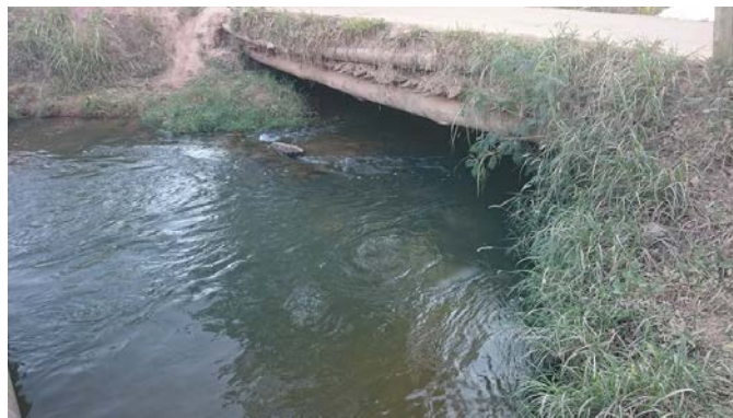
Figura 9: Detalhe da ponte sustentada por madeira.
