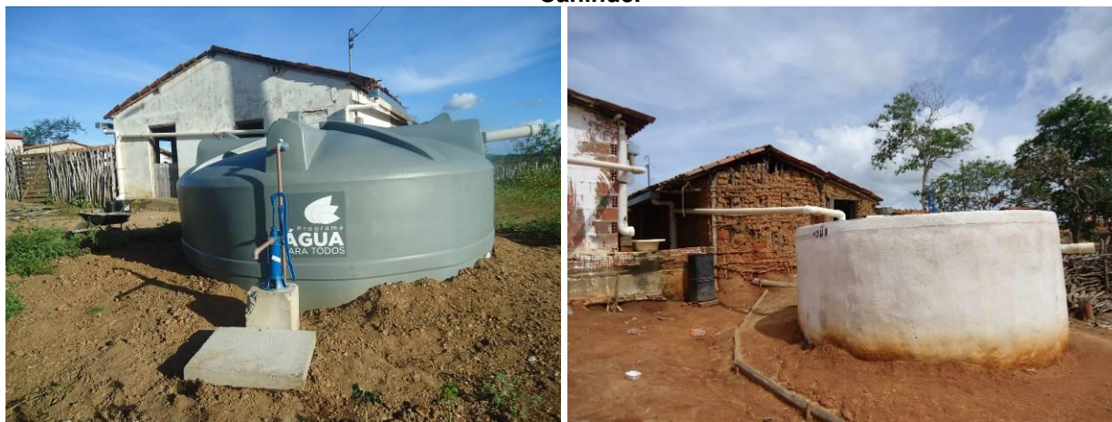
Figura 1: Cisternas de polietileno e de placas instaladas na localidade de Sítio do Meio, município de Canindé.
