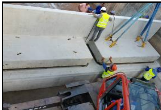
Foto 4 – Fusegate assentado, visto de montante.
