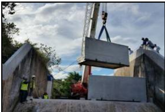
Foto 3 - Vista de montante do assentamento dos Fusegates.
