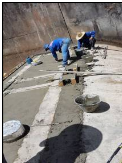
Foto 8 – Vista da ampliação do vertedouro, observando-se os pedestais de contenção (montante para jusante).
