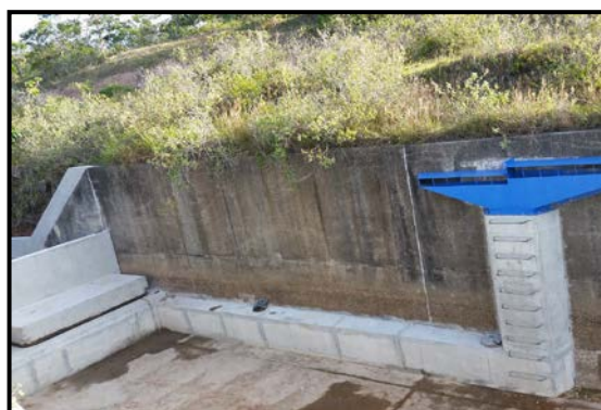
Foto 6 – Vista do Fusegate e do poço de alimentação, visto de montante.
