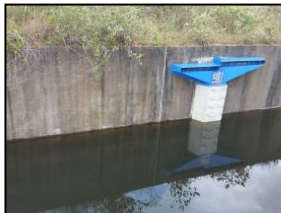
Foto 10 – Vista do poço de alimentação, a montante do vertedouro (NA 16,35; em 05/10/16).
