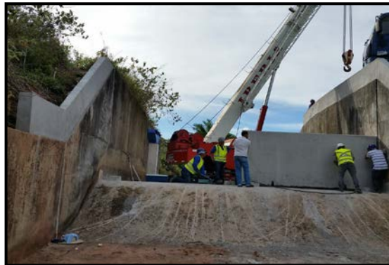
Foto 2 – Vista de jusante do assentamento dos Fusegates.
