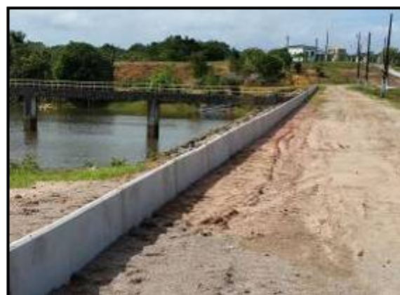
Foto 12 – Vista da estrutura de concreto instalada para elevar o bordo livre da barragem.
