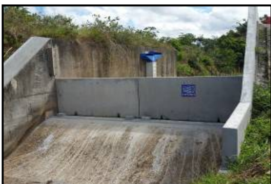
Foto 5 – Fusegates assentados, visto de jusante.
