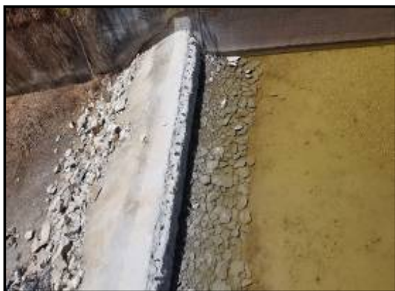
Foto 7 – Vista do vertedouro original (jusante para montante).
