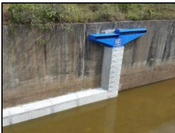
Foto 9 – Vista do poço de alimentação, a montante do vertedouro (NA 14,53; em 17/06/16).
