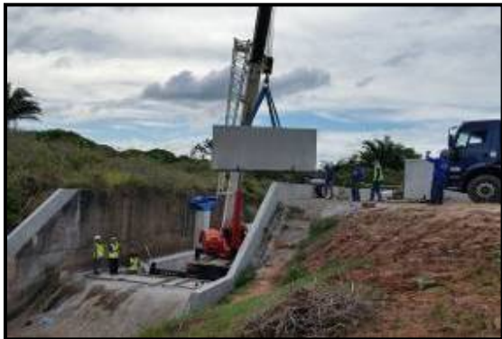
Foto 1 – Vista da base de assentamento dos Fusegates.
