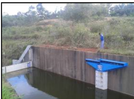
Foto 11 – Vista dos Fusegates e do poço de alimentação (NA 16,34; em 24/05/17).
