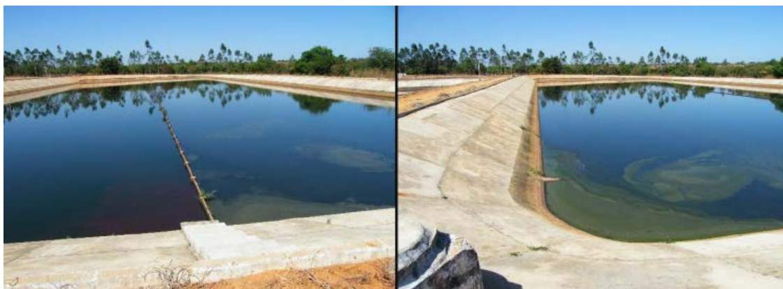
Figura 04: Lagoa facultativa da ETE Aureny
