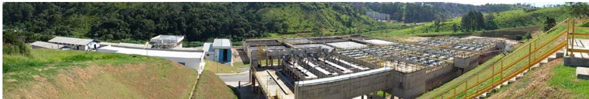
Figura 1: Vista Geral da ETE
