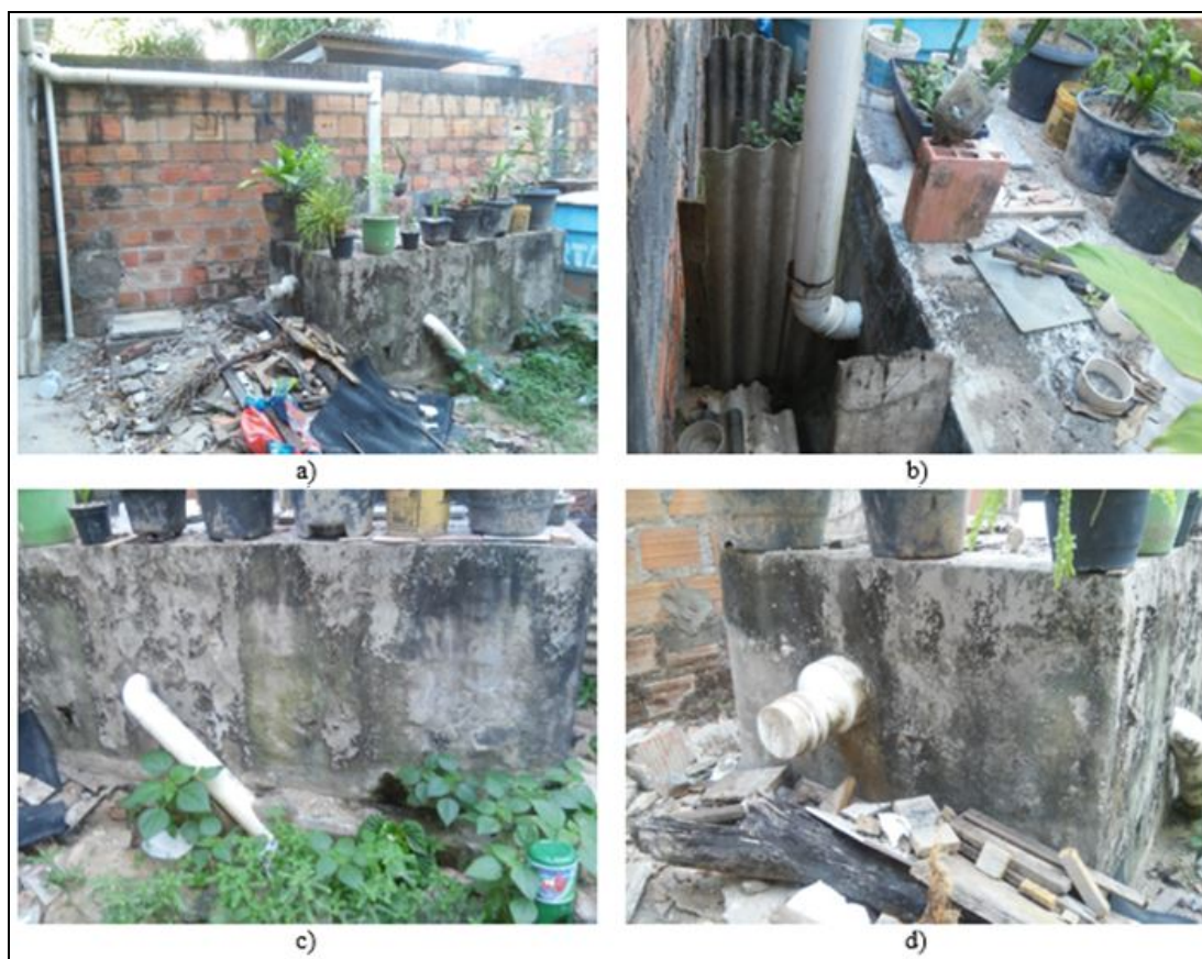
Figura 1 - a) Sistema Fossa câmara única; b) Entrada do efluente; c) Saída do efluente; d) Acesso para sucção.
