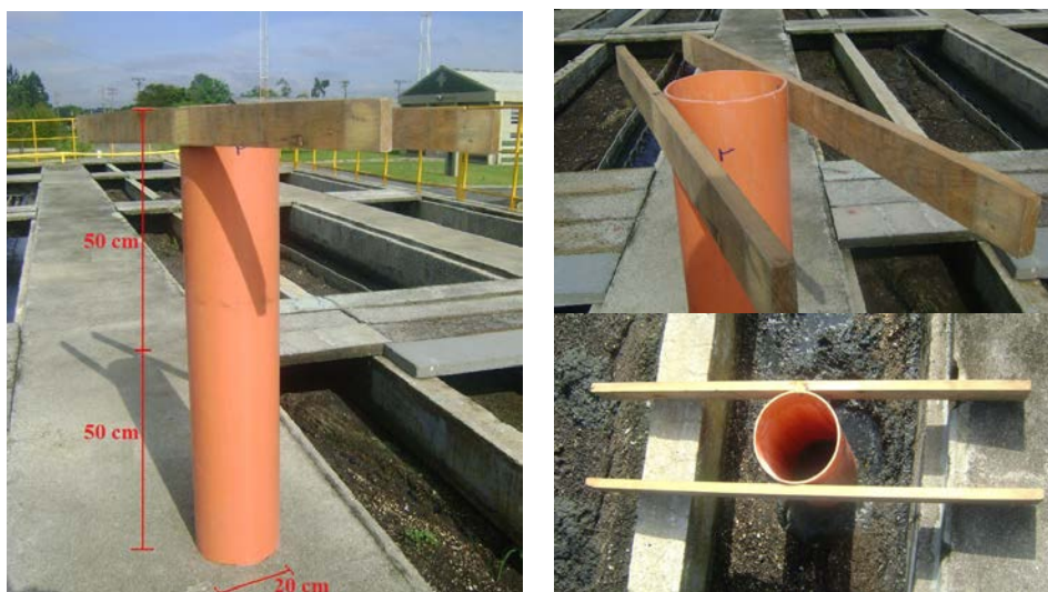
Figura 3: Fotografia do tubo armazenador de espuma. Fonte: os autores.
