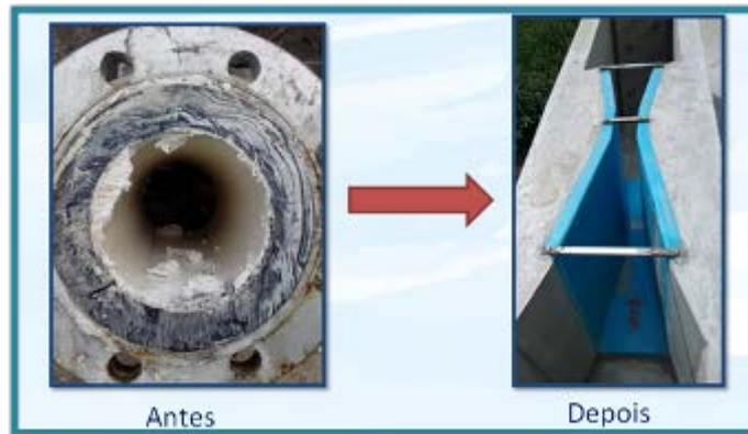
**Figura 3 - Antes e depois do método de medição da vazão do leite de cal**
