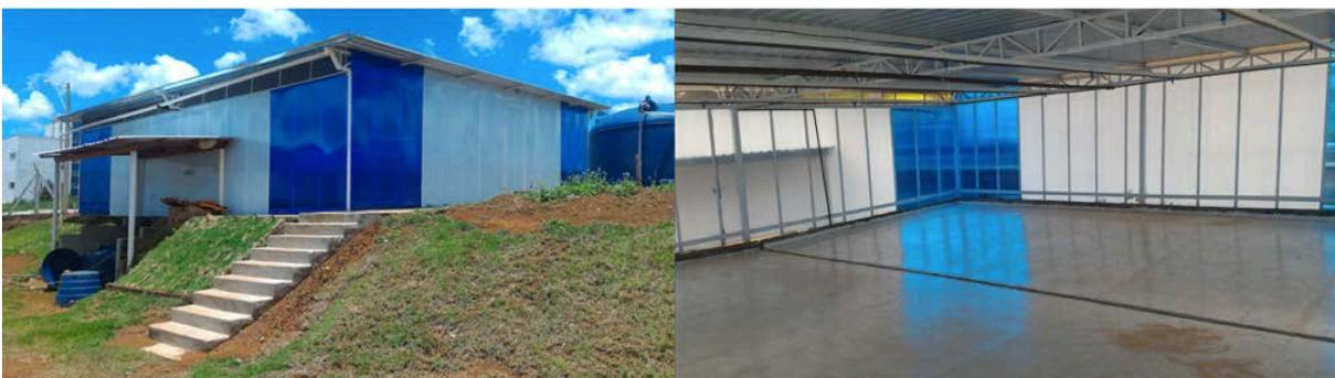
**Figura 1 - a) Estrutura que protege o simulador de chuva; b) superfície impermeável**
