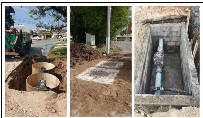
Figura 3 - Execução das caixas com anéis em ferro fundido e blocos de concreto.
