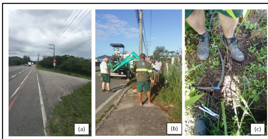
Figura 8 - DMC 4 - Vargem Pequena: (a) Local onde se encontrava o PEAD - dentro do mangue; (b) execução da substituição do PEAD pela calçada; (c) ligação clandestina encontrada.
