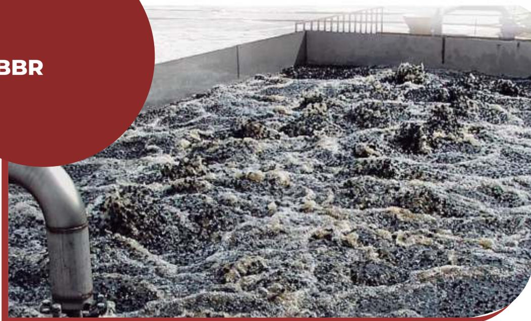
O sistema biológico com Reatores de Leito Móvel com Biofilme (Moving Bed Biofilm Reactor - MBBR) possibilita o crescimento da biomassa em meio suporte plástico, onde permanece em mistura constante dentro do reator aerado. O emprego de meio suporte possibilita o aumento de área superficial para o crescimento de biomassa e consequente elevação do tempo de retenção celular.
