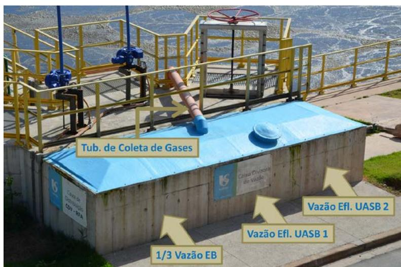
**Figura 2: Caixa de Distribuição de Vazão e Tubulação de Coleta de Gases**
