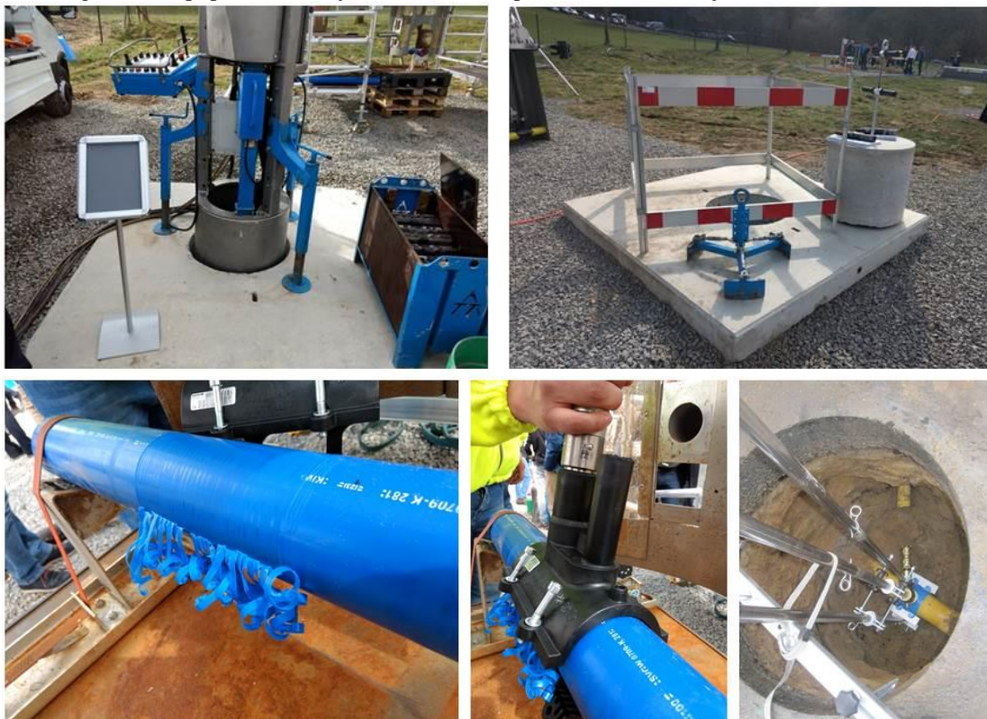
Figura 2 – Equipamento “Keyhole” – Corte de pavimentos e instalação de redes e ramais.
