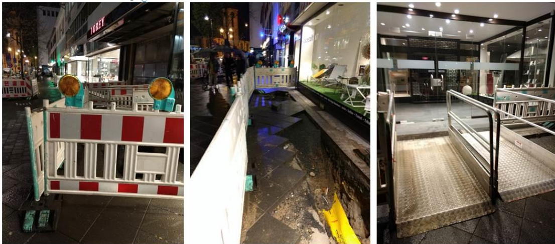
Figura 8 – valas a céu aberto na Cidade de Frankfurt à noite.
