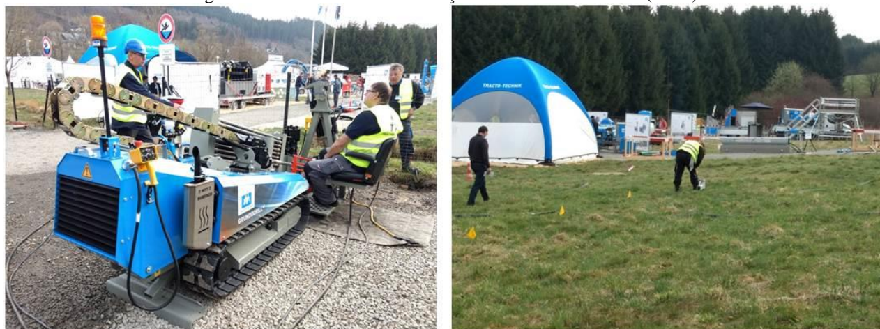
Figura 4 – “Grundodrill” – Perfuração Direcional Horizontal (HDD).
