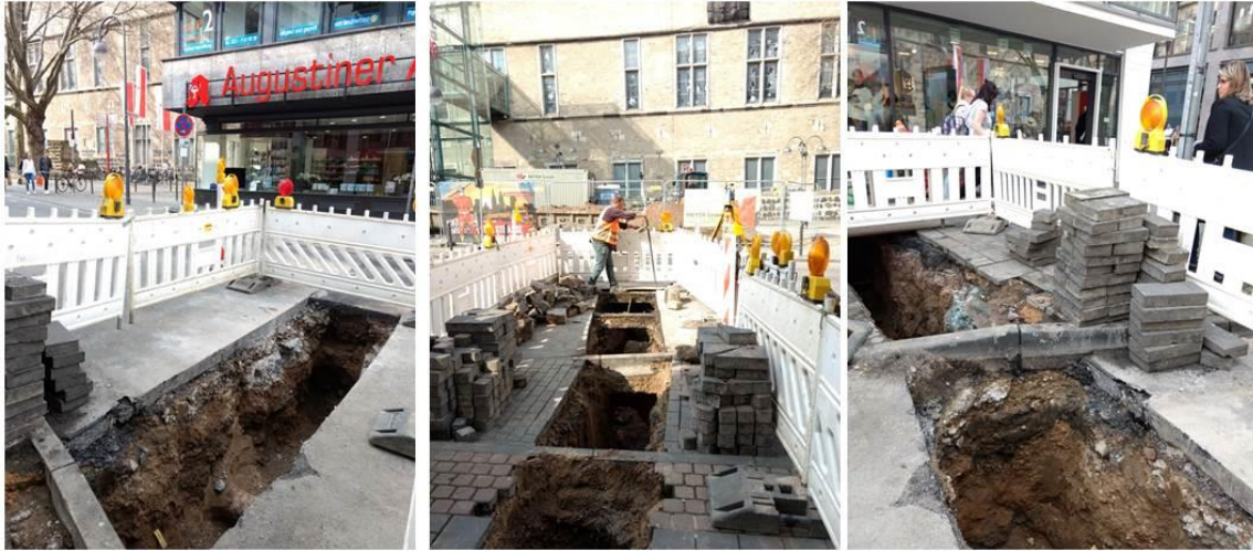
Figura 7 – valas a céu aberto na Cidade de Colônia.
