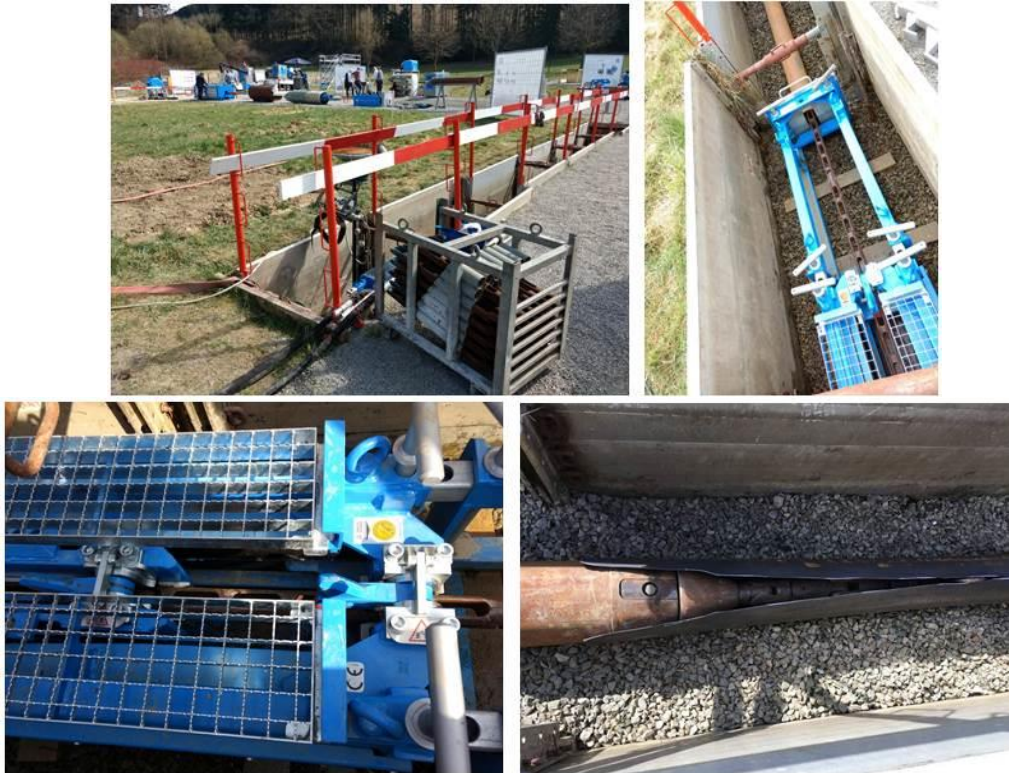
Figura 6 – O “pipebursting” e o sistema de encaixe por hastes metálicas com fendas.
