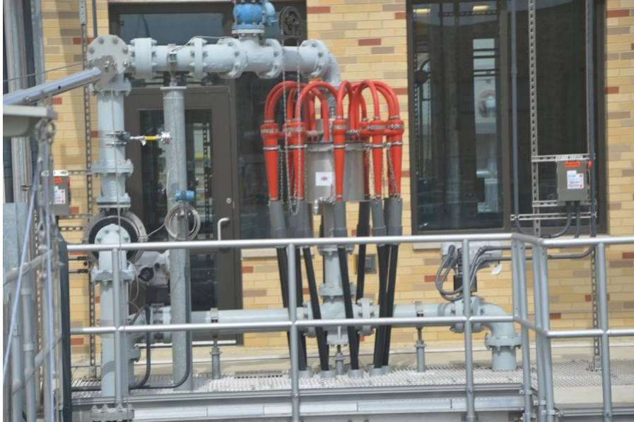
Figura 3.13: Seletor externo de Lodo Granular do Reator DEMON da Planta Blue Plains da DC Water
