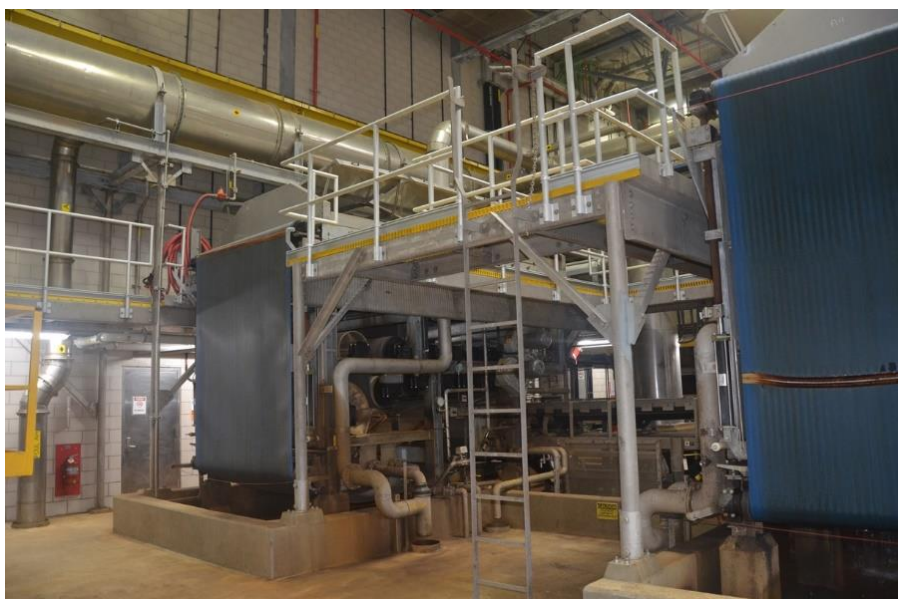
Figura 3.8: Filtros Prensa de Esteira para Desidratação do Lodo da Planta Blue Plains da DC Water
