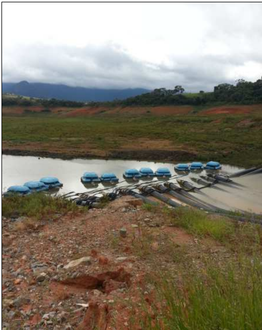
Figura 3: Bombas utilizadas na captação da reserva técnica
