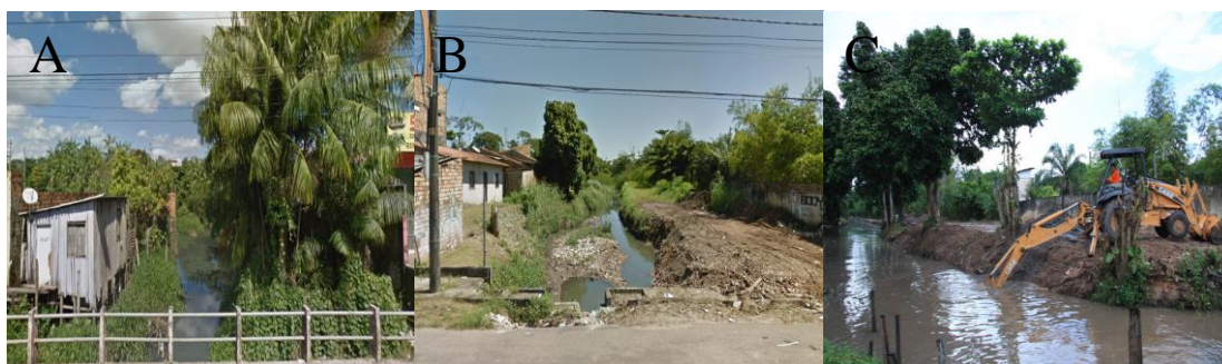
Figura 08: A) Canal da Independência, B) Canal da Rodovia Hélio Gueirros; C) Dragagem
