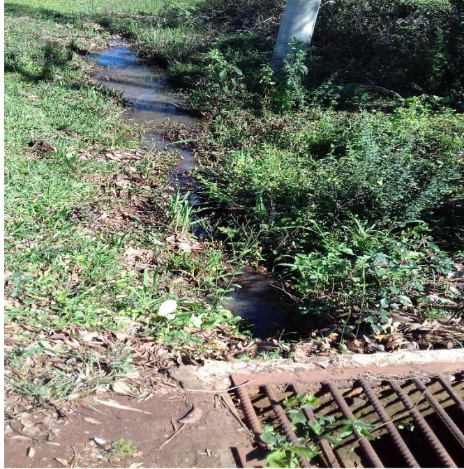
Figura 3: Esgoto a céu aberto.
