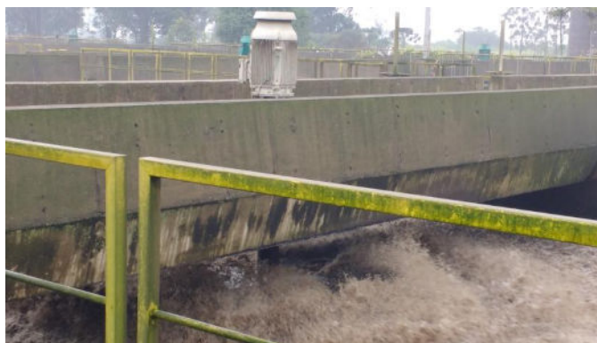
Figura 01 – Aerador Superficial do Tanque de Aeração
