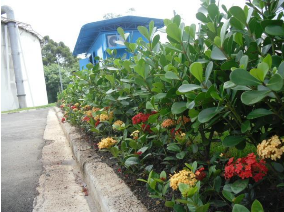
Figura 10: Vista da BFT Tamboré (entrada de reservatório) (fonte: Sabesp-2018).
