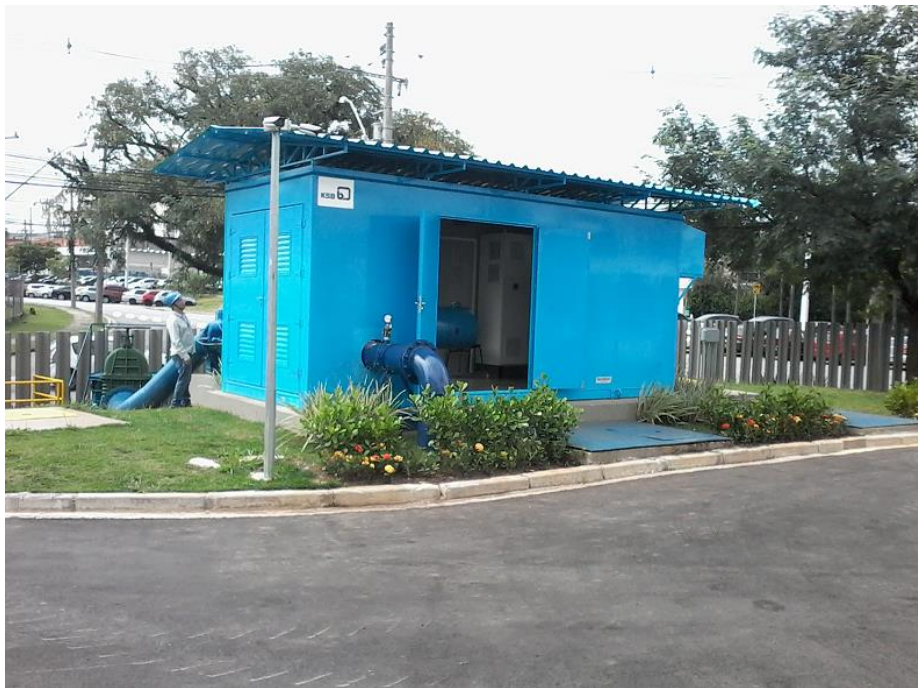
Figura 11: Vista da BFT Tamboré (vista para o logradouro) (fonte: Sabesp-2018).
