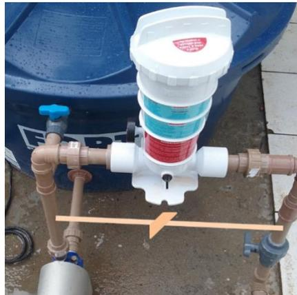
Figura 7 – Sistema para cloração com pastilhas.
