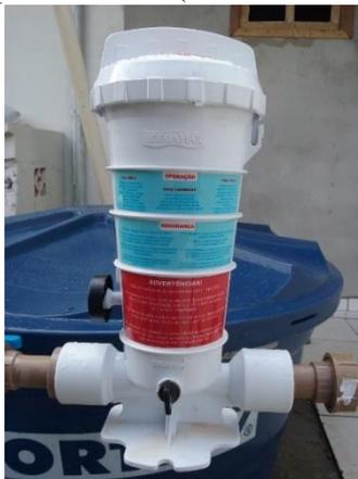
Figura 4 – Sistema para desinfecção por cloro em pastilhas.
