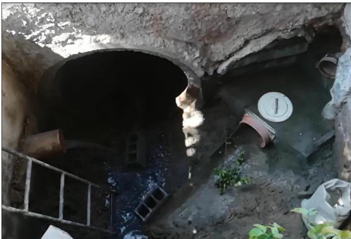
Figura 1: Galeria de Água Pluvial onde ocorreu o desvio e captação de esgoto.
