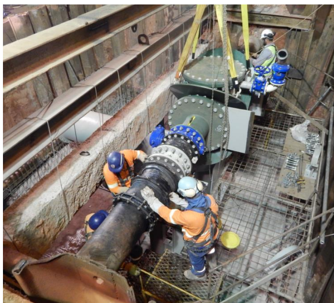
Figura 5: Montagem da Interligação da adutora secundária com a adutora existente Vargem Grande Caucaia
