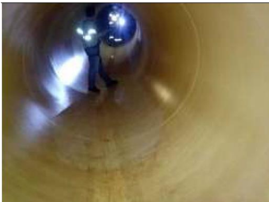
Figura 6: Limpeza e Inspeção interna da Adutora Principal.
