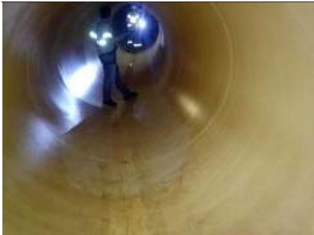
Figura 14 - Limpeza e Inspeção interna da Adutora principal.
