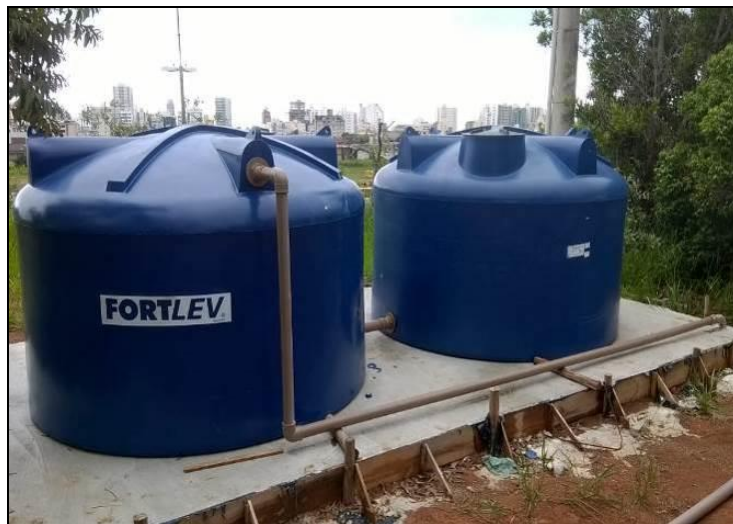
Figura 4. Reservatórios ETE Aeroporto - capacidade total de 30 m 3 .
