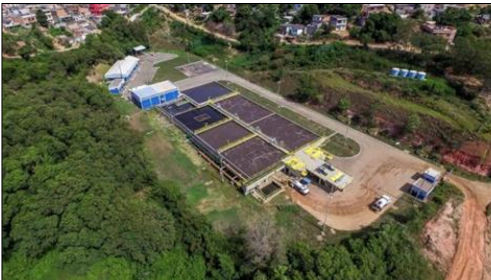
Figura 1. Vista aérea ETE Bandeirantes.
