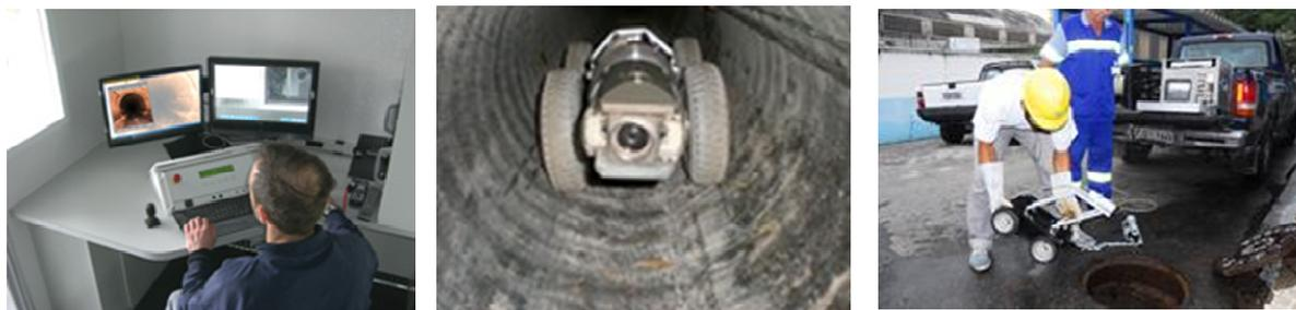
**Figura 3- Inspeção de linhas de esgoto com a utilização da tecnologia de filmagem robotizada com circuito fechado de televisão**
