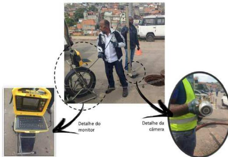
**Figura 17 – Monitoramento da rede de esgoto**
