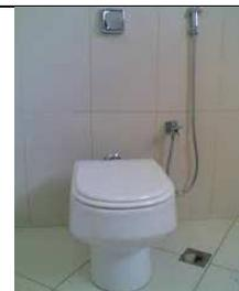
**Figura 8 - bacia com válvula de descarga.**
