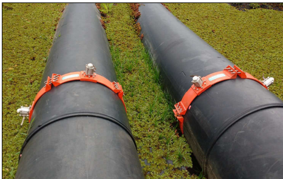
Foto 01 - detalhe da instalação das abraçadeiras em trecho alagado
