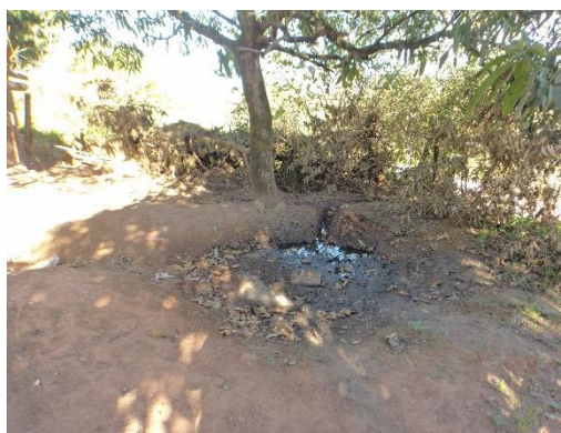
Figura 3: Fossa rudimentar com vazamento
