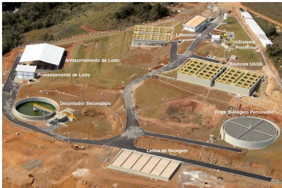
Figura 2: Fotografia aérea da ETE Vassoural em obras. Fonte: Arquivo fotográfico SANEPAR (2010)
