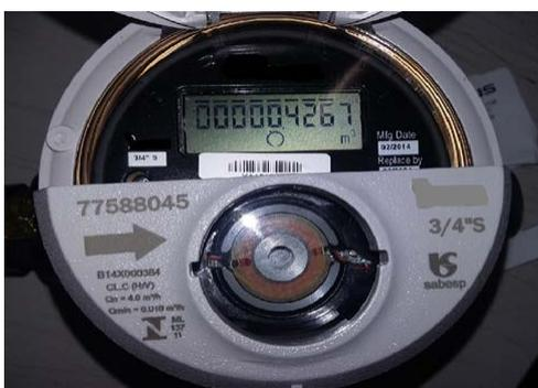
Figura 5 : Medidor Eletromagnético - cavalete diâmetro 3/4”
