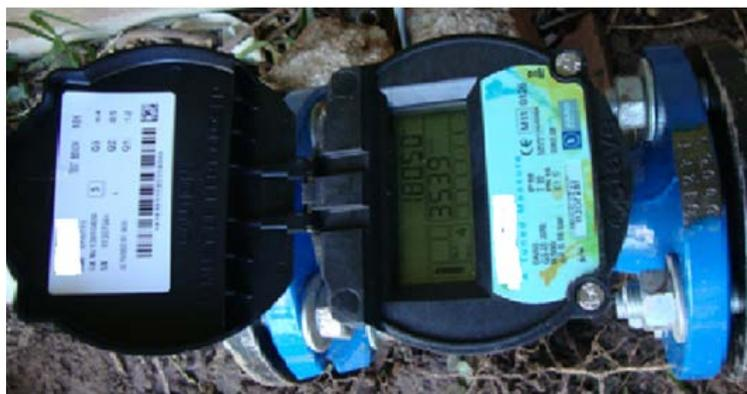
**Figura 3 : Medidor Ultrassônico – cavalete diâmetro igual a 2”**
