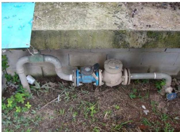
**Figura 1 : Conjunto filtro e medidor velocimétrico tipo Woltmann**
