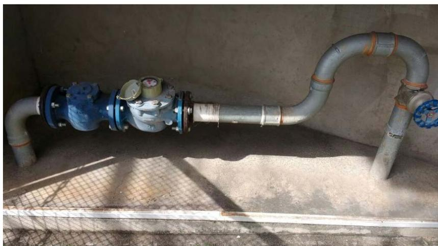
Figura 10 : Pré troca – medidor velocimétrico woltmann (mecânico)
