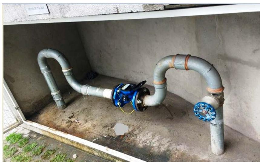
Figura 11 : Pós troca – medidor ultrassônico (estático)
