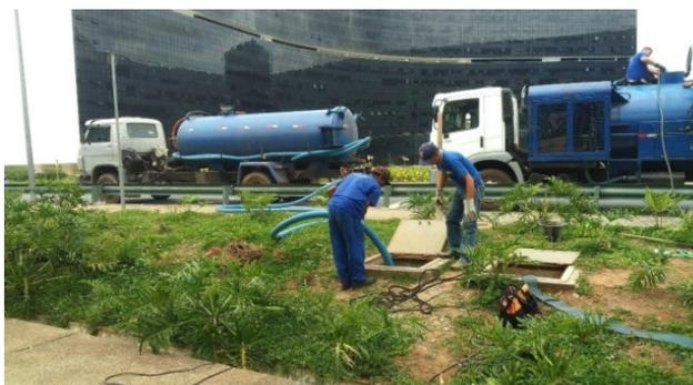
**Figura 7 - Limpeza do reservatório de reuso**
