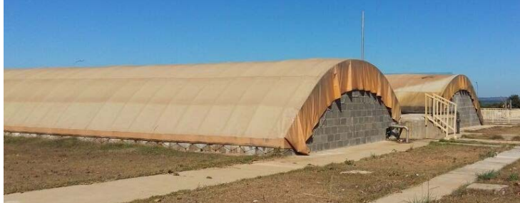
Figura 05: Reatores UASB da ETE Norte
