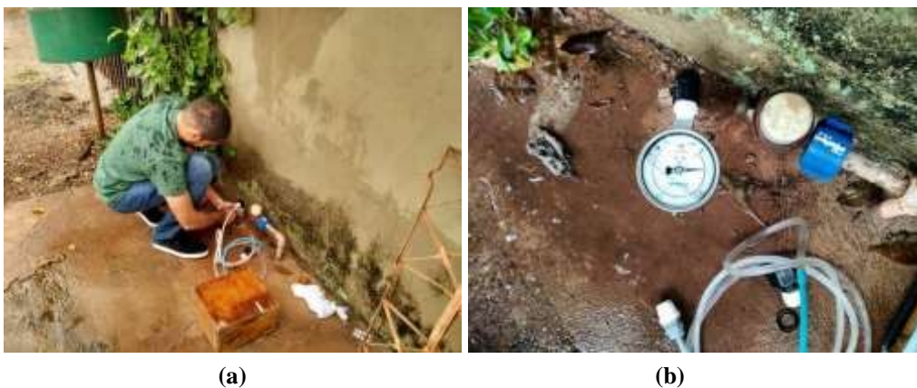
(a) (b) Figura 4. (a) Reservatório escolhido; (b) Reservatórios presentes na ETA.
