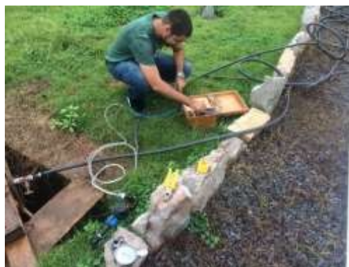
Figura 6. Instalação do dispositivo em um ramal do booster.
