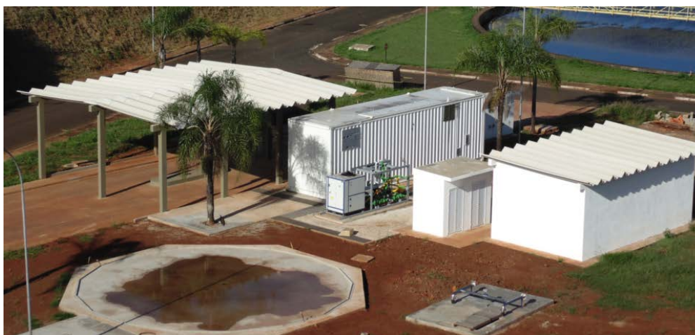
Figura 5 – Vista da área de implantação do Sistema de beneficiamento, com a unidade de beneficiamento, ao centro, a base para reservatório de biogás, à frente, a estação de compressão de biometano à direita e a área coberta para instalação do posto de abastecimento dos veículos à esquerda (Sabesp- RG, /0/2017).
