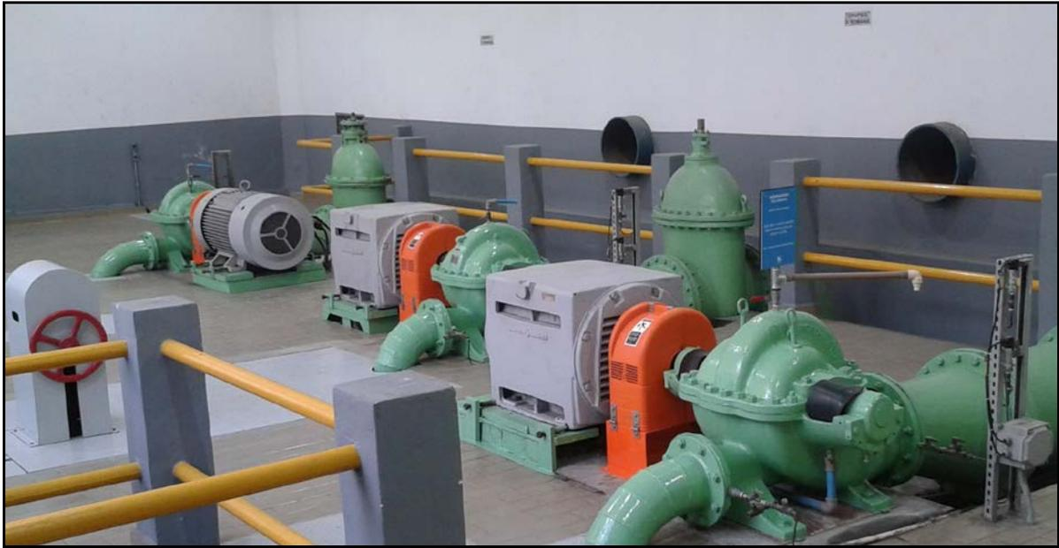
**Figura 4: Estação de Bombeamento – Visão interna dos conjuntos moto-bomba**
