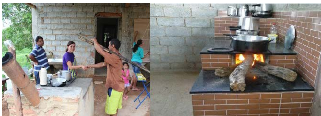
Figura 3. Reforma realizada na residência do agricultor familiar Sebastião.
