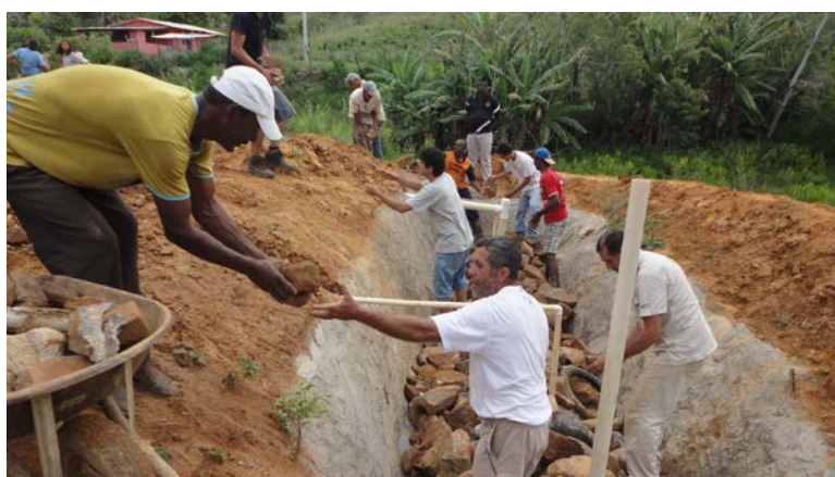
Figura 2. Mutirão de construção do tanque de evapotranspiração na residência do agricultor Everaldo, Viçosa – MG.
