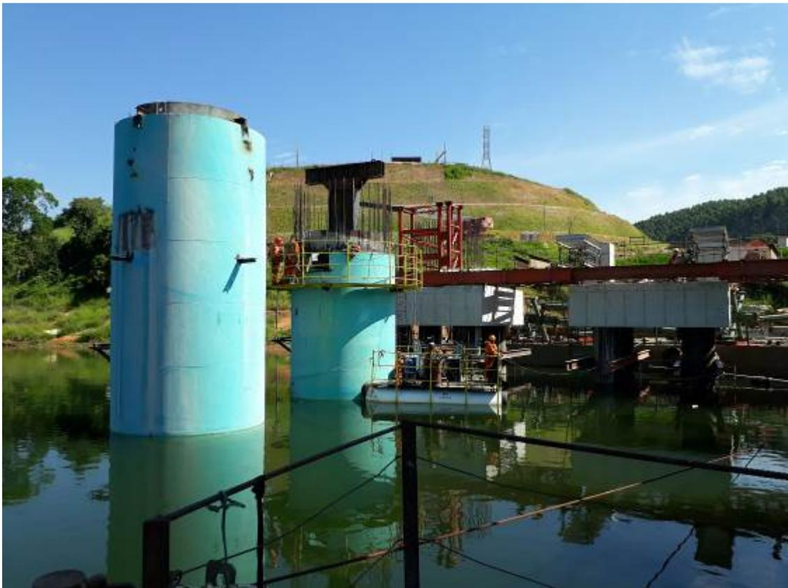
**Figura 16: Poços das bombas de sucção da EEAB Jaguari em execução**
