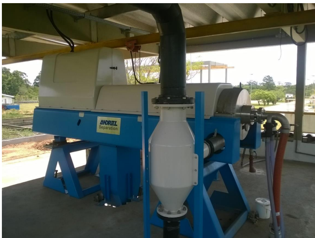
Figura 9: Decanter centrífuga Andritz instalado numa estação de tratamento de esgoto
