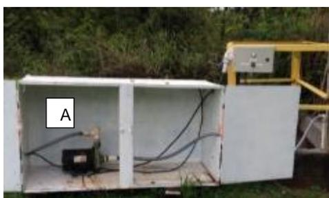
**Figura 2 (A) Bomba de esgoto**
