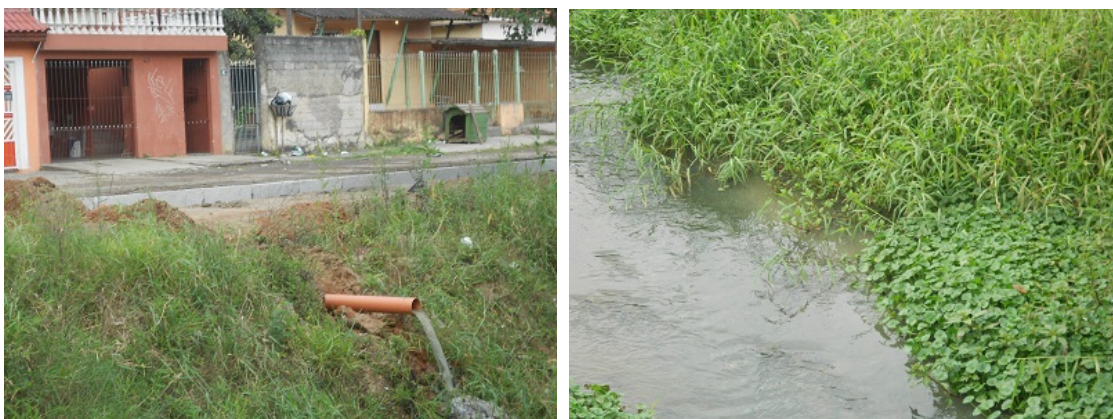
Figura 2: Exemplo de retirada de lançamento de esgoto do corpo d'água (antes)
