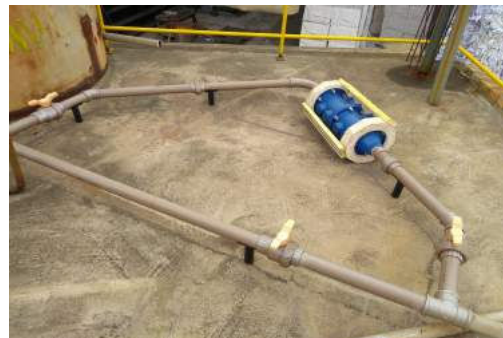
Foto 5 – Detalhe do Catalisador Solavite Hydro CS-04 com isolamento de PVC
