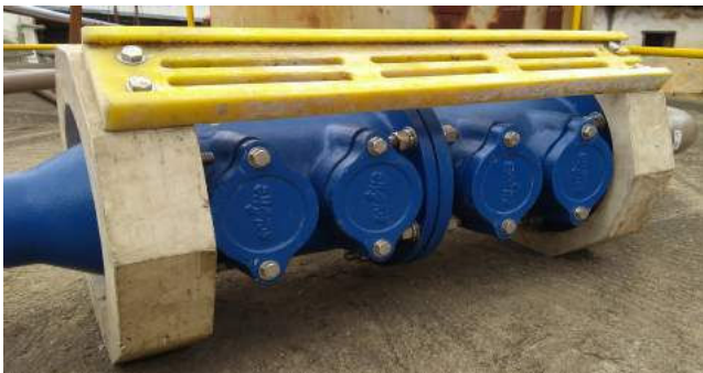
Foto 5 – Detalhe do Catalisador Solavite Hydro CS-04 com isolamento de PVC
